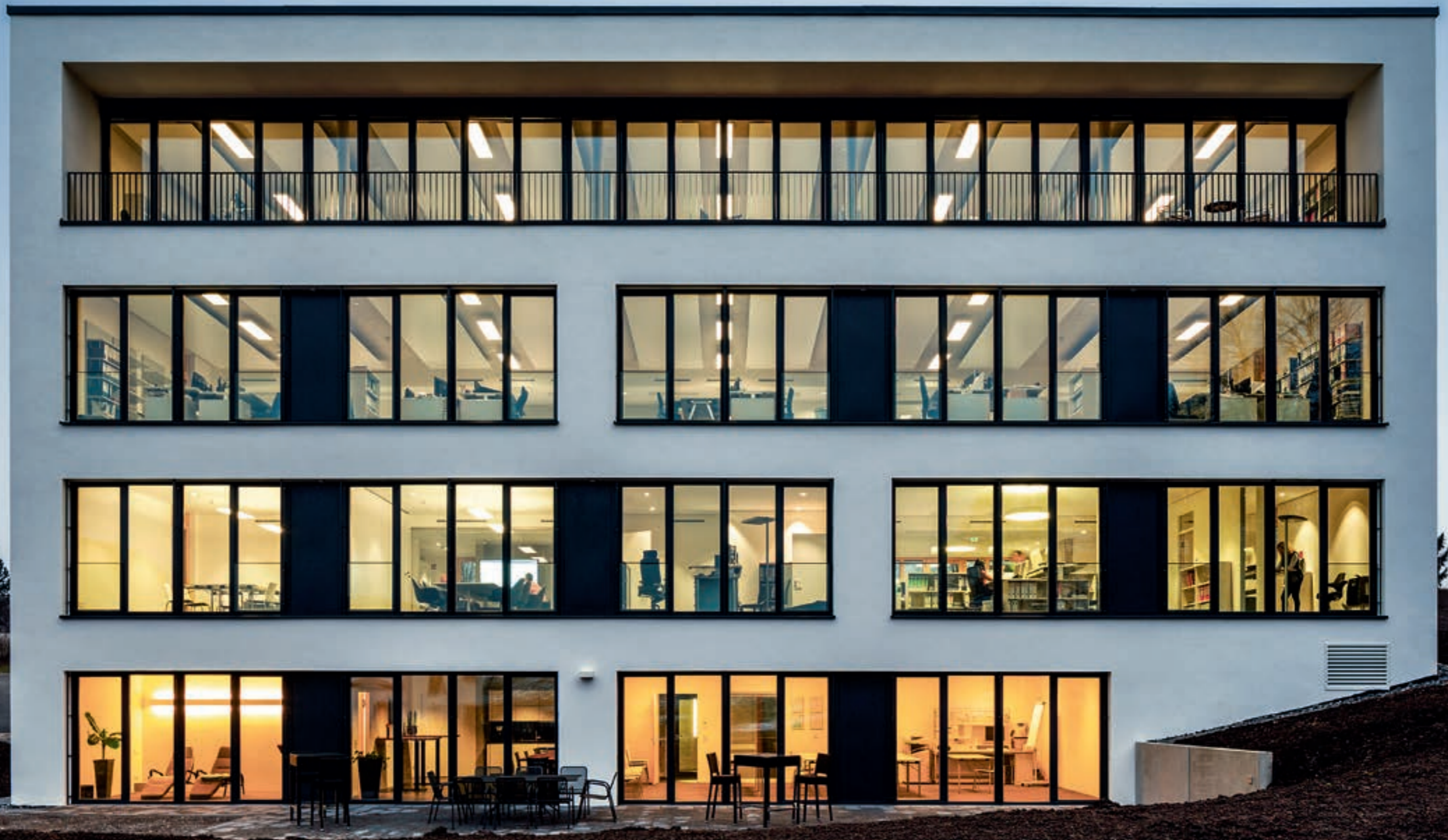
Bürogebäude des Ingenieurbüro Sulzer GmbH & Co. KG in Vogt
