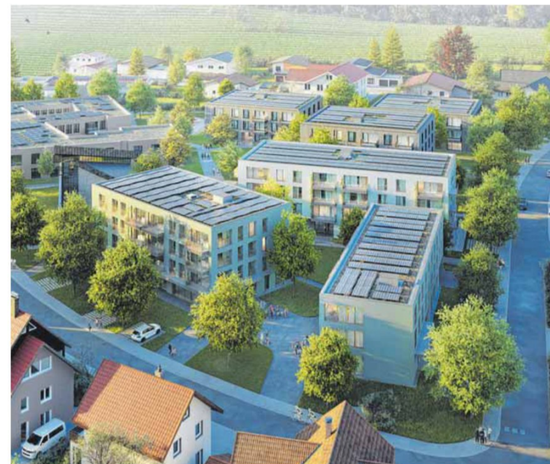
So wird das „Vinzenz Areal“ mit seinen sechs neuen Gebäuden zwischen Baumannstraße (unten) und Humbrechtser Straße (rechts) spätestens Anfang 2024 ausschauen.
