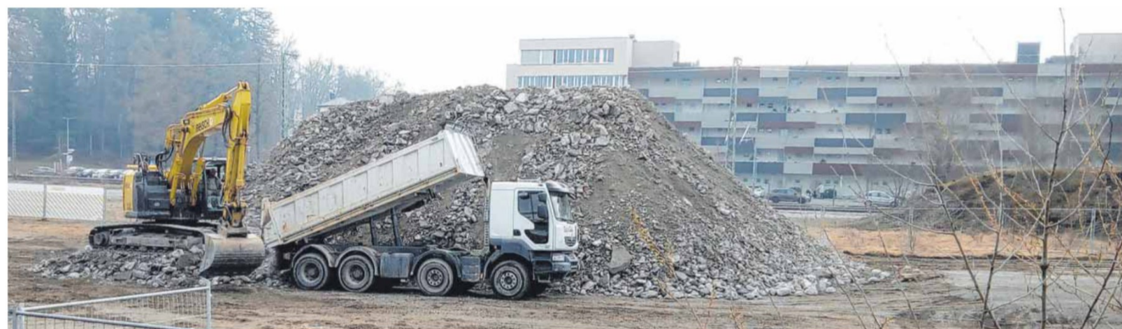
Laster fahren das Abbruchmaterial von der Baustelle auf die Kutter-Brache nördlich der Bahnschienen.
